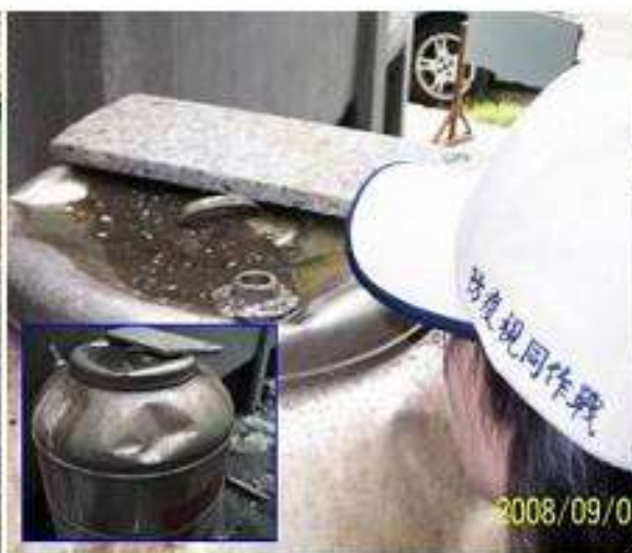
儲水桶鐵蓋凹陷處
