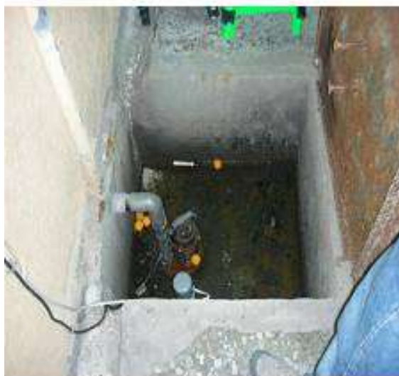
地下室集水槽
