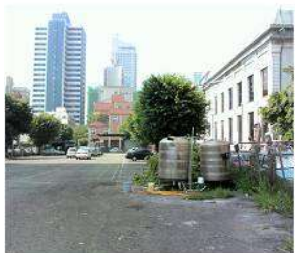
停車廠水塔無蓋
