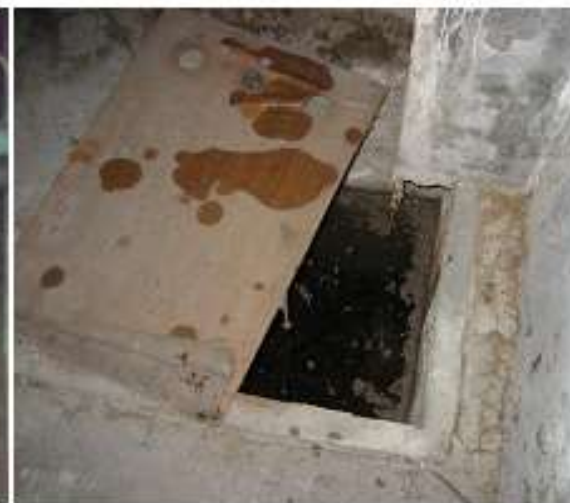
地下室污水池
