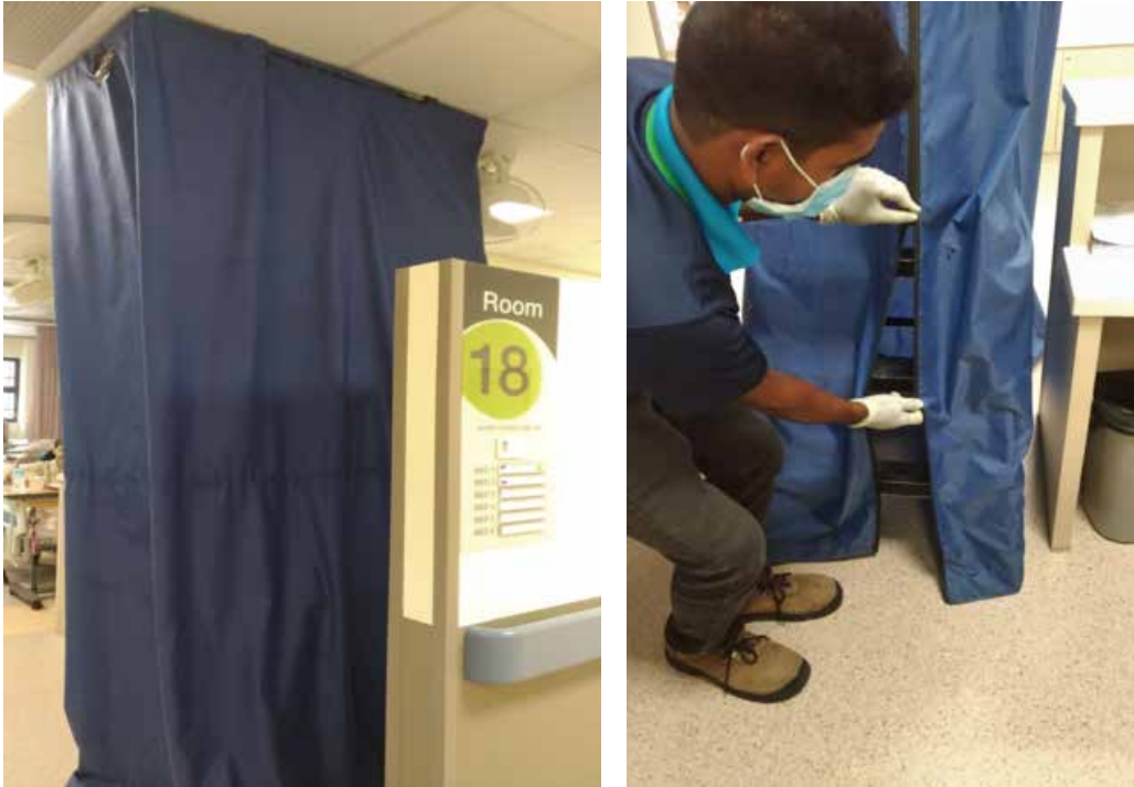
圖四 工程專用罩子(由天花板至地上)
