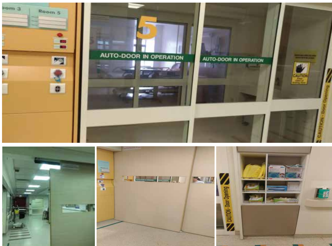
圖六 負壓隔離加護病室；走道設有隱藏門，於高傳染性疾病時可將區域再區隔，並有完善PPE設備
