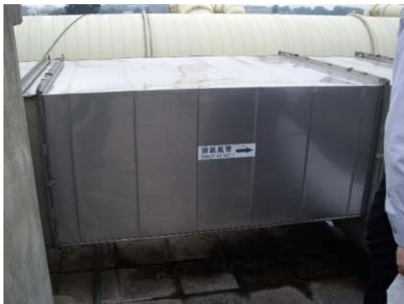
圖六、螺旋（或折鐵）排氣風管沒有氣密
