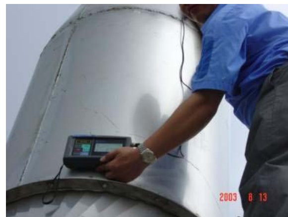
圖七、煙囪出口風速量測
