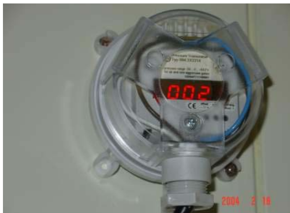
圖八、實驗室壓力計在開門時應該壓力平衡(壓力差為零)
