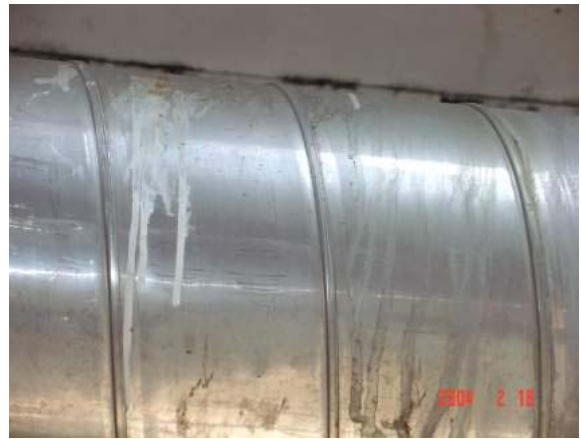
圖五、螺旋（或折鐵）排氣風管沒有氣密
