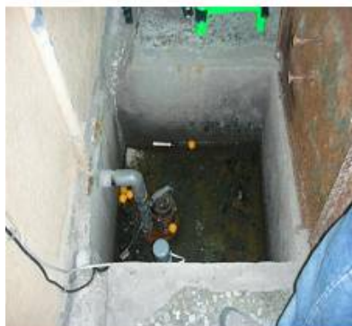
地下室集水槽
