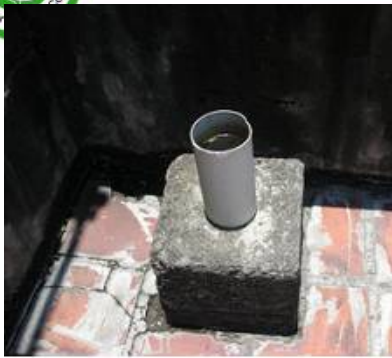
水泥樁上之水管
