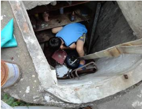
北區五福里自強街34巷3號旁空地防空洞，深約3公尺，積水約10公分並孳生登革熱病媒蚊子
