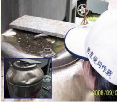
儲水桶鐵蓋凹陷處
