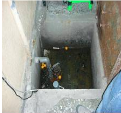
地下室集水槽
