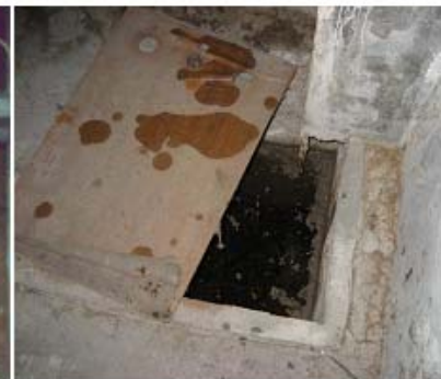
地下室污水池
