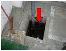
北區國姓里地下室停車場消防池積水(有加蓋細紗網但未密封有空隙)孳生病媒蚊子
