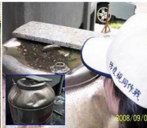
儲水桶鐵蓋凹陷處
