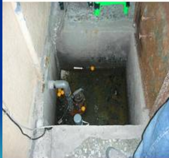
地下室集水槽
