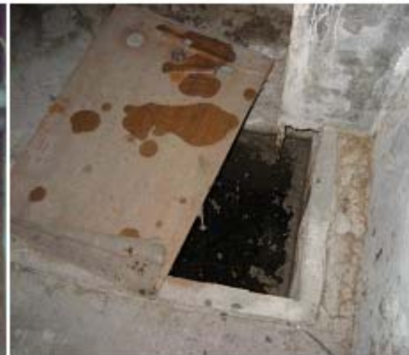
地下室污水池
