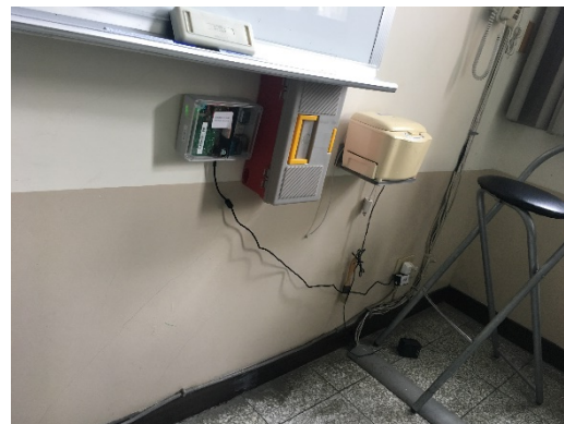
圖 33. 臺師大進修推廣學院306教室
