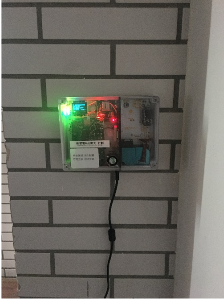
圖 34. 臺師大進修推廣學院 1102教室
