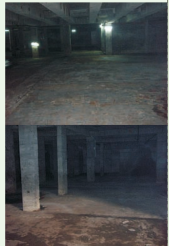
■ 正仁里地下室改善後樣貌
