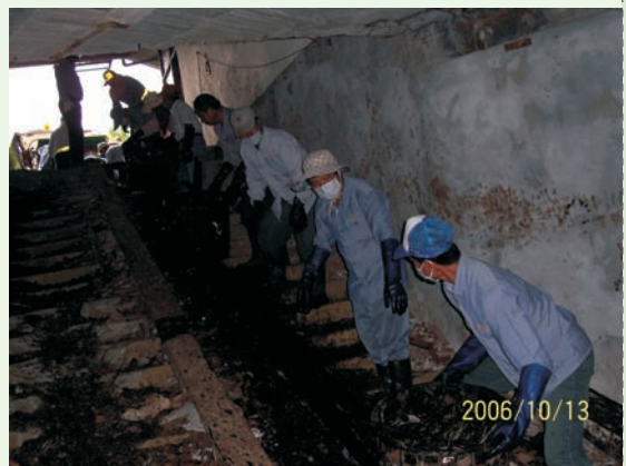
■ 地下室清理情形
