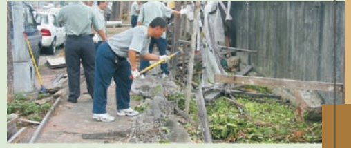
■ 拆除翠華路鐵路沿線違建物
