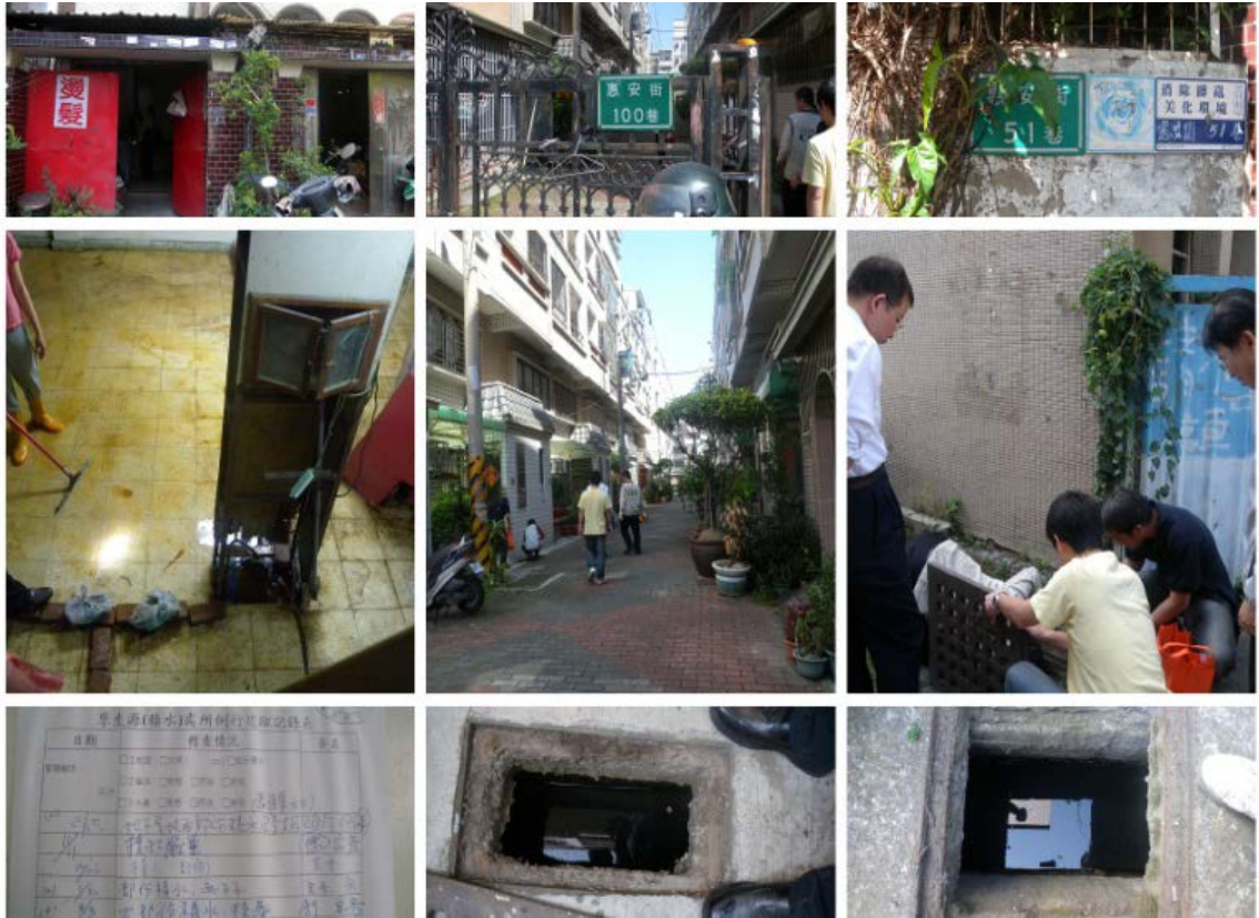
圖八 場勘台南積水地下室與水溝
