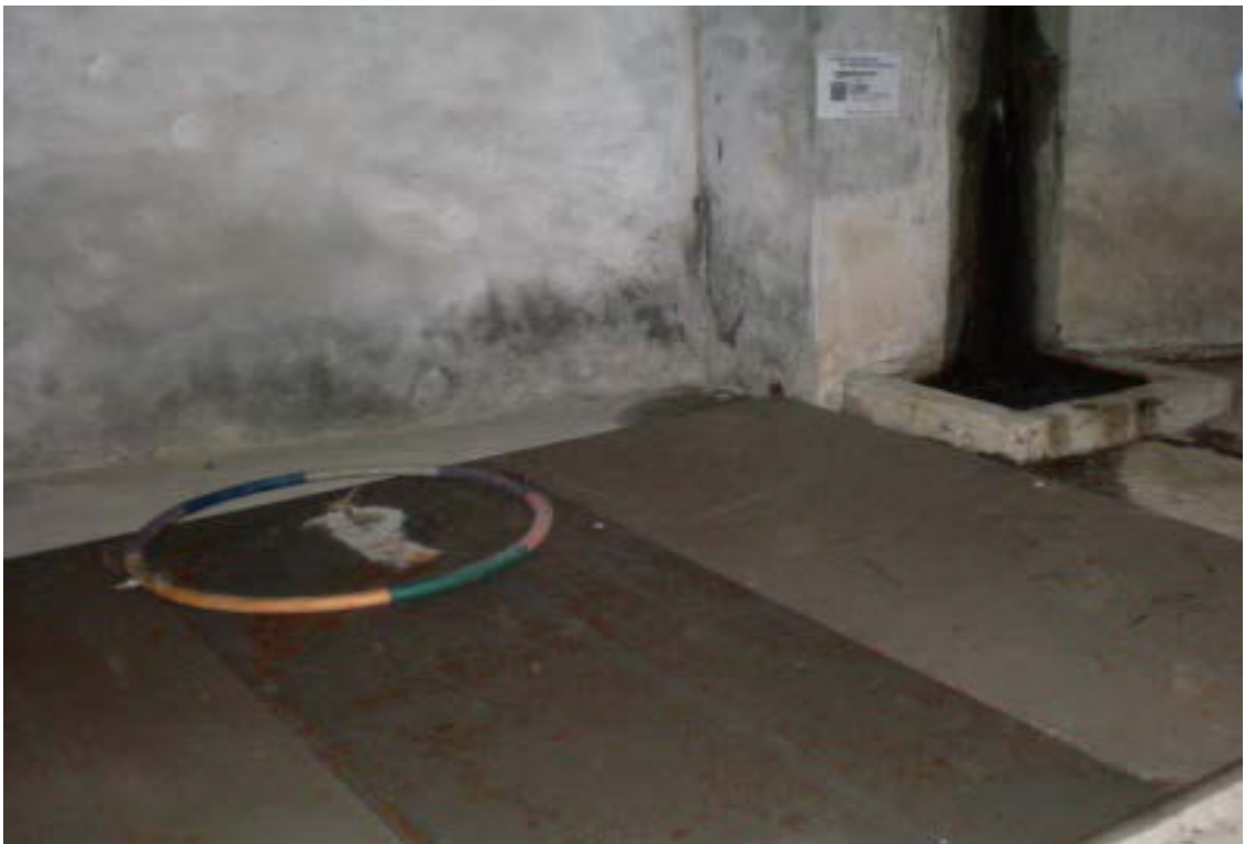
圖 8. 第四型積水地下室：水質清澈乾淨的大面積中度積水。 上圖為下左為楠梓區國昌里德 O 路 998 號~996 號地下室；下圖為苓雅區民主里大順三路 000 號地下室/鐵板底下整個大片地下室積水。
